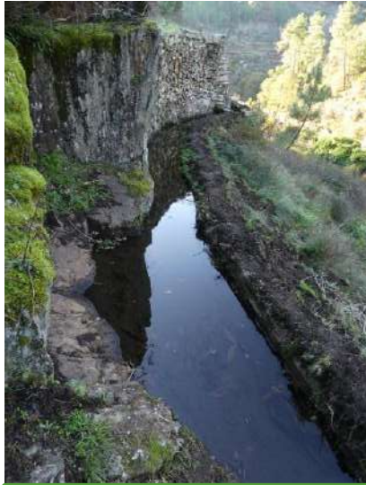
Recuperação da levada
